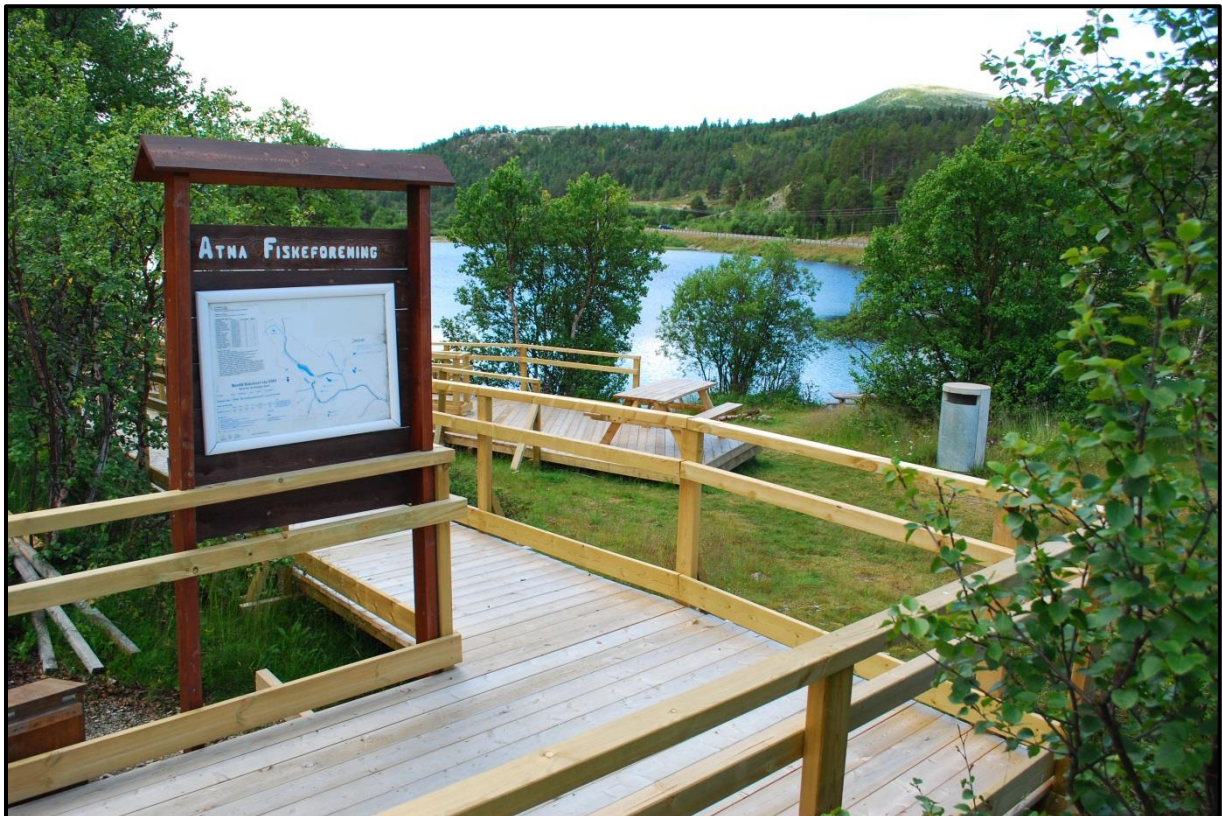
Tilrettelegging for fiskere ved Rundtjønn. (Foto: Sollia Fjellstyre)
