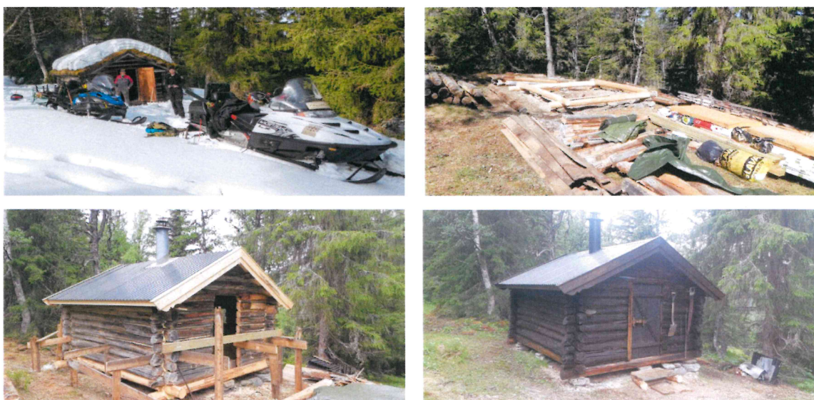
Bilde 2: Kvannslåbua, nyoppusset og klar for bruk!
